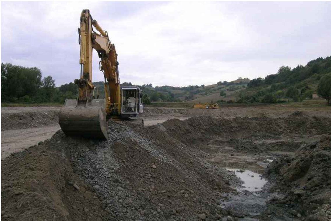
Rivabella (1 ottobre 2010): ripresa da SE verso NW del lotto attualmente in coltivazione; sulla destra si nota la porzione in cui la superficie risulta ribassata di due mandate (circa - 6.0 m) rispetto al piazzale circostante, avendo così raggiunto il fondo del giacimento ghiaio-sabbioso ed il tetto delle argille azzurre di substrato, che dovranno a loro volta essere parzialmente scavate per ricavare parte del materiale necessario alla costruzione degli argini perimetrali di cassa.
