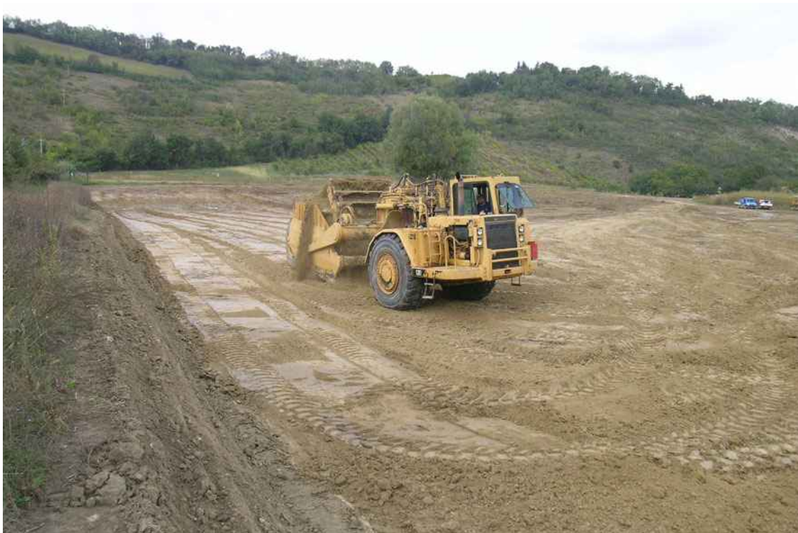
Rivabella (1 ottobre 2010): il fotogramma mostra lo scraper impiegato per lo scotico di uno dei lotti della cassa in sinistra; tale macchina movimento terra è fornita di tagliente e cassone per il caricamento delle terre che può essere effettuato mediante un dispositivo elevatore applicato anteriormente ad esso. Lo scarico del cassone può essere effettuato per mezzo di comandi meccanici, oleodinamici o per gravità, andando nel caso in questione a depositare il materiale decorticato nelle aree di sedime degli argini perimetrali di cassa.
