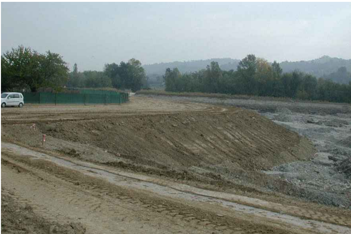
Rivabella (15 ottobre 2010): il fotogramma mostra il tratto nord -orientale dell'invaso della cassa posta in sinistra idraulica rivestito di terre di cappellaccio di riporto, che costituirà la base dell'argine perimetrale di cassa elevato fuori terra, come realizzato dalla Società Lavino 2003 sulla base degli atti progettuali depositati.
