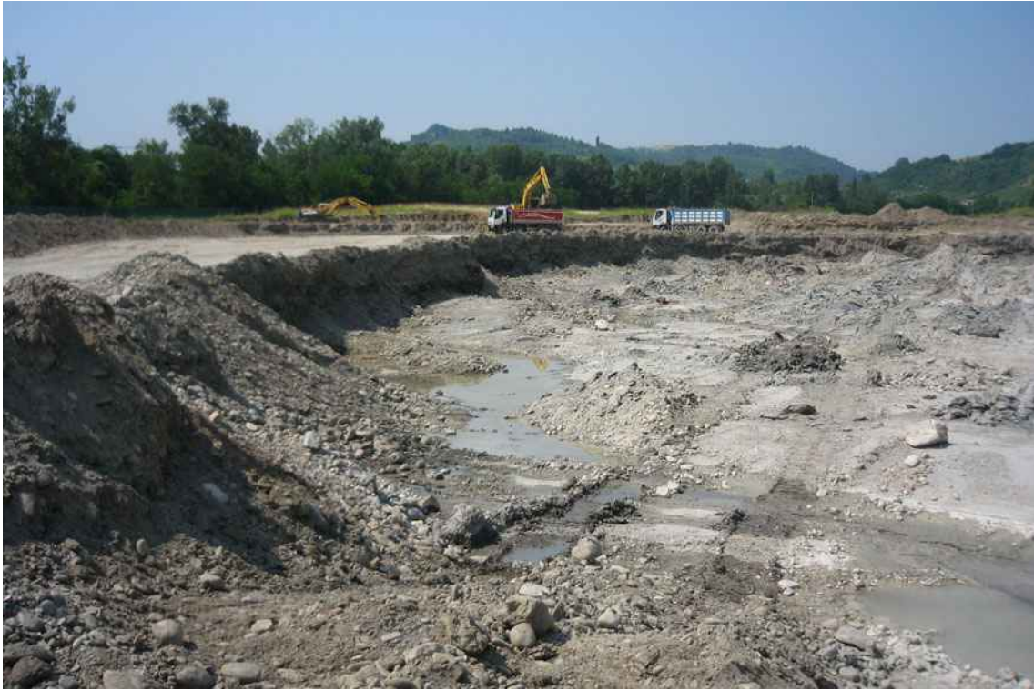
Rivabella (1 luglio 2010): ripresa da E verso W del settore centrale del terrazzo alluvionale posto in sinistra idraulica del corso d'acqua, attualmente interessato dai lavori di coltivazione; sullo sfondo è visibile un escavatore che con la benna da 2 mc carica autoarticolato in 3 ÷ 4 minuti.
